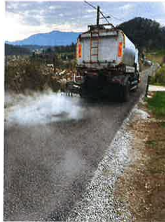
Slika 1. Radovi na modernizaciji NC
